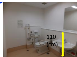
入口幅が115cmあり、1階のトイレよりスペースに余裕があります。
