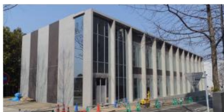
▶ フロンティア研究棟の外観（3月12日撮影）
