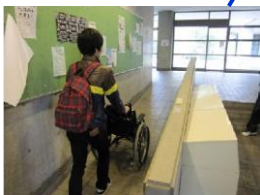
階段の脇にはスロープがあります。傾斜は約5度です。
