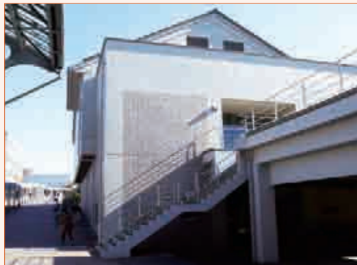
32 AV棟 CALL、視聴覚設備を備えた3教室とAVライブラリから構成されています。
