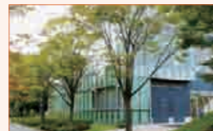
31 プロジェクト研究棟 大型プロジェクトや、大学独自の重点的な研究のための施設です。各研究者がそれぞれの研究に最適な設備を導入し、良好な研究環境のもとで高度な研究を行っています。
