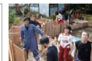
■ 版築を自力建設でつくる
