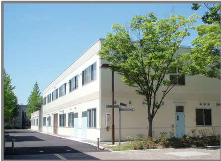
栄養・食品科学 / 生体機械工学研究棟
