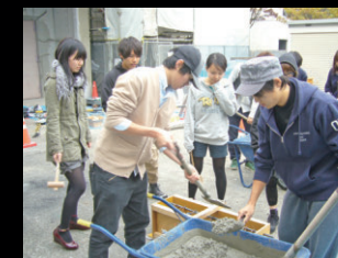
建築構造実験(3年)のコンクリート打設の様子
